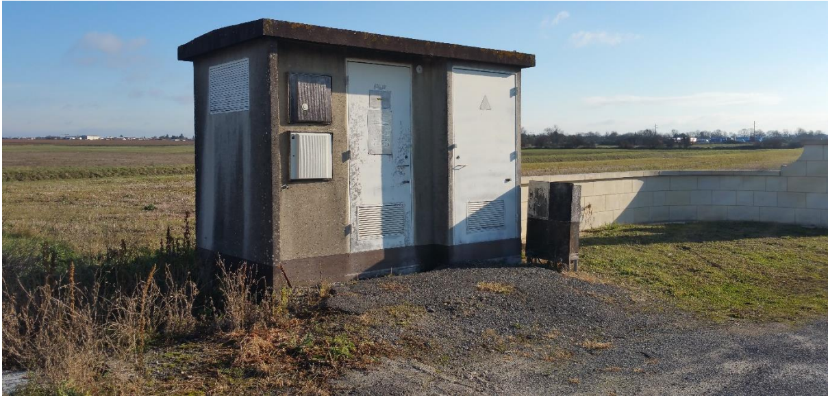
Photo n° 13 : Le transformateur alimentant le site
